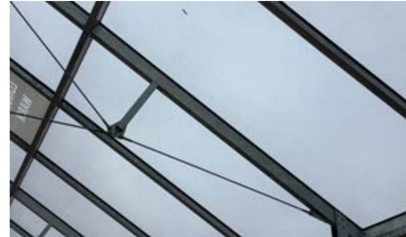
Illustration 1 :Prise de vue photographique de la Verrière par les élèves, en se focalisant sur certaines caractéristiques architecturales (vitre, charpente métallique, poutre transversale...)
