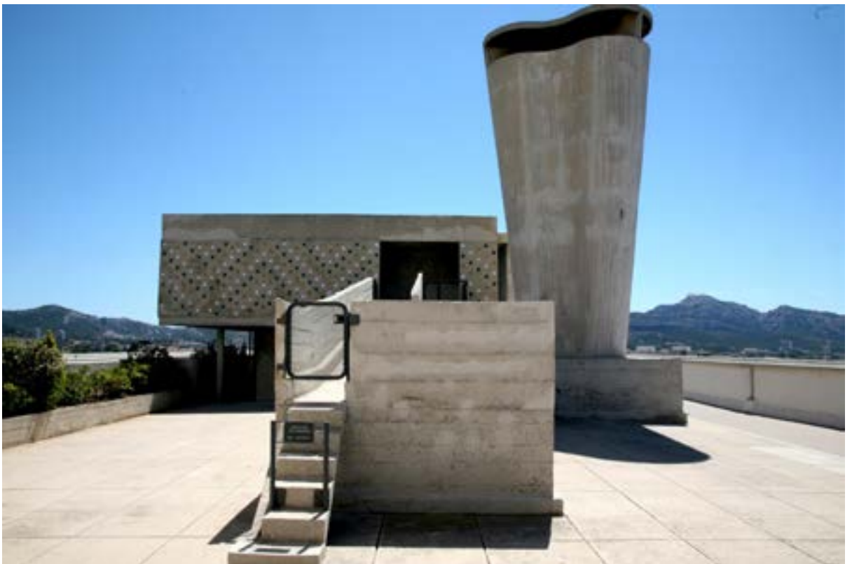
Toit terrasse de la Cité Radieuse, Marseille, Le corbusier
